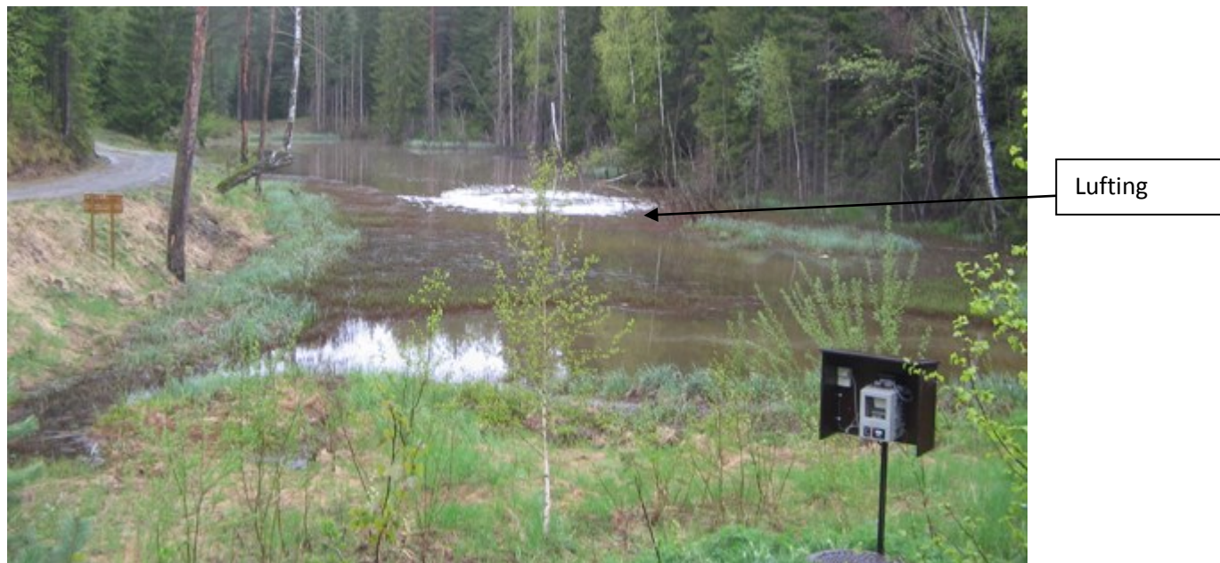
Figur 12 Sedimenteringsbasseng (biodam) med lufteanlegg der sigevann fra begge deponiene ledes. Vann fra bassenget slippes ut i Lågen etter rensing. (Norconsult 2011.)
